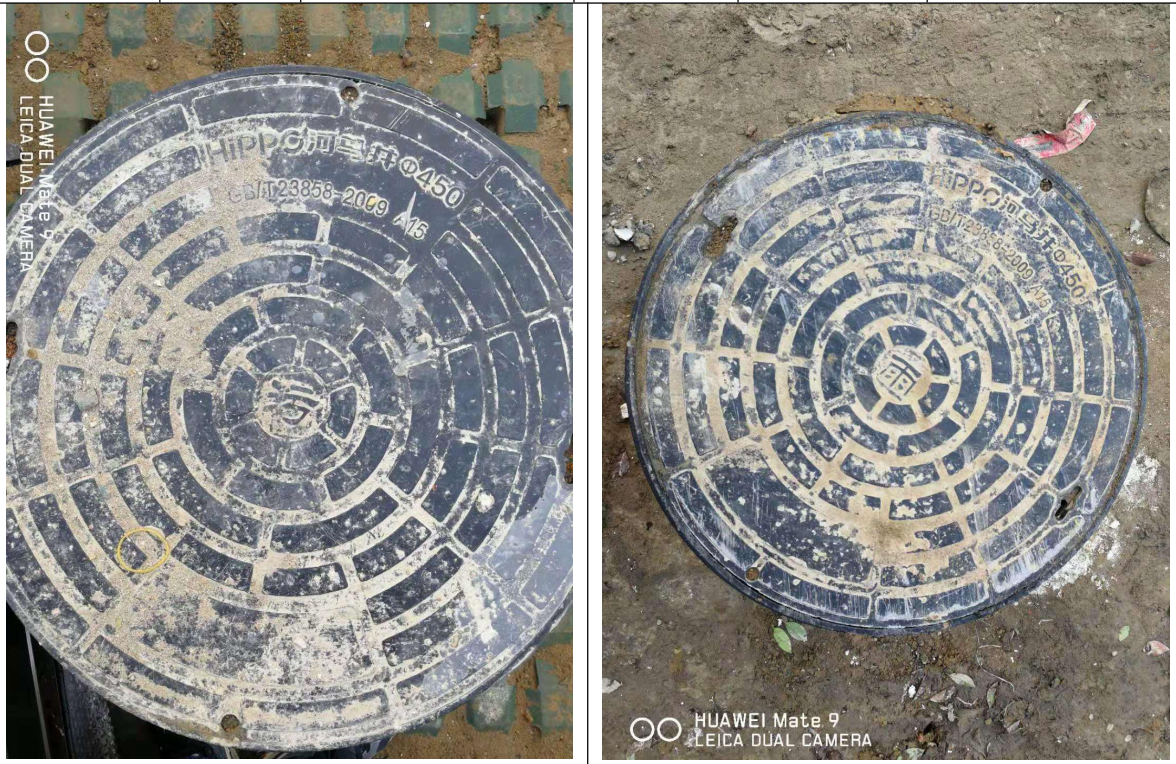
图 4.1-1 项目污水排放口及雨水排放口
