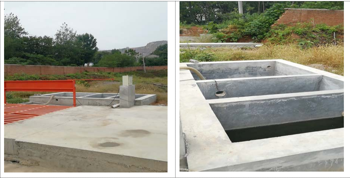
图 3 车辆、设备清洗废水沉淀池
