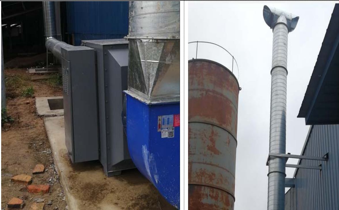
图 3 废气处理设施及排气筒现场照片
