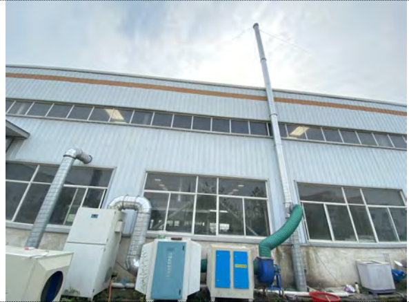
2#排气筒废气处理设施
