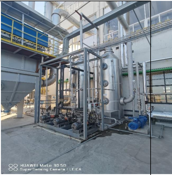
甲醇蒸馏系统尾气吸收系统（两级水喷淋+两级活性炭）
