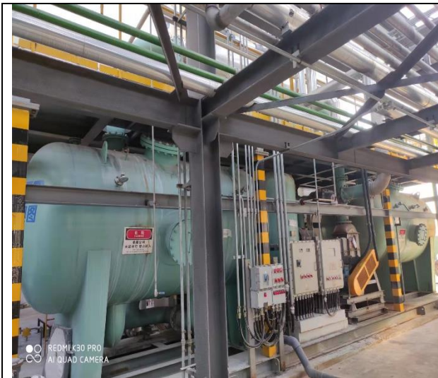
环氧氯丙烷废气处理系统（两级活性炭纤维吸附）
