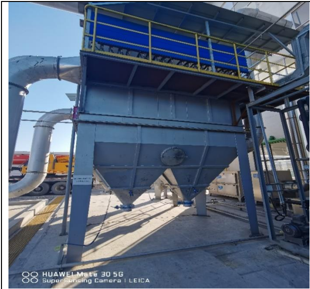
造粒工序尾气处理系统（布袋除尘）
