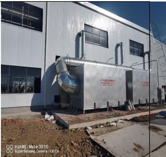
板框压滤机和废水蒸馏废气处理系统 （两级活性炭吸附）
