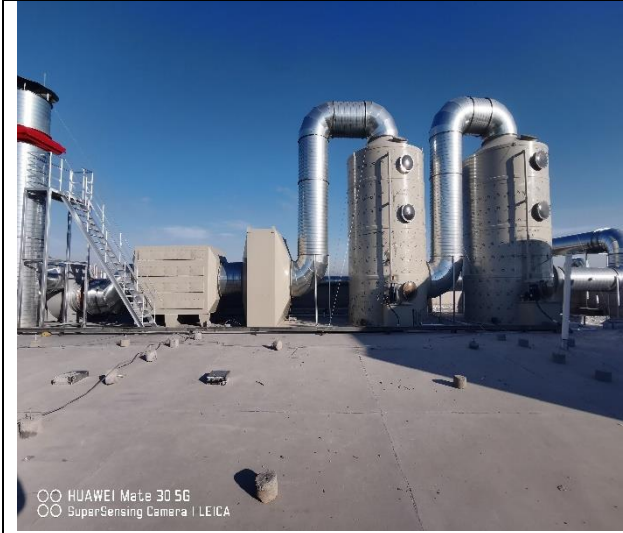
造粒工序有机废气处理系统（二级水洗+除湿器+二级活性炭）
