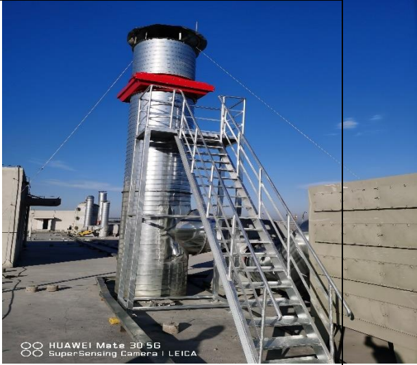
甲醇蒸馏系统尾气吸收系统（两级水喷淋+两级活性炭）
