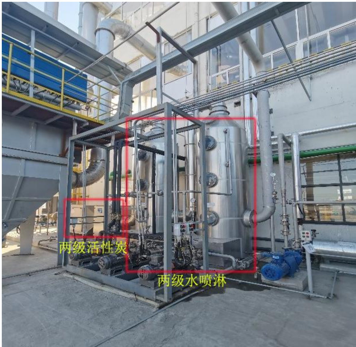
图 3-1 现有工程“两级水喷淋+除湿+两级活性炭”处理装置
