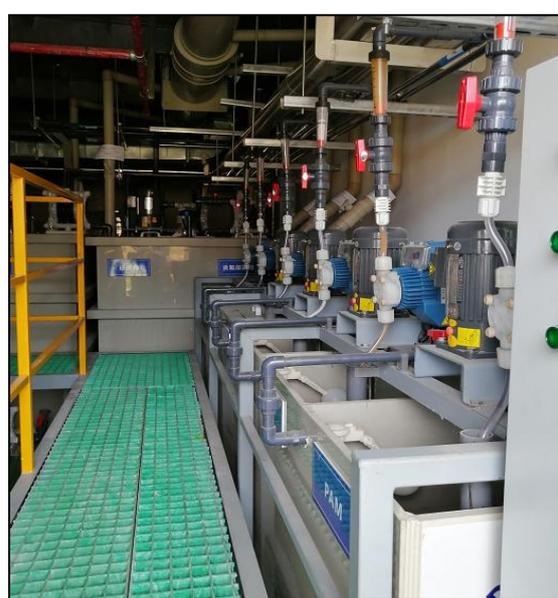
含铬废水处理系统-反应槽
