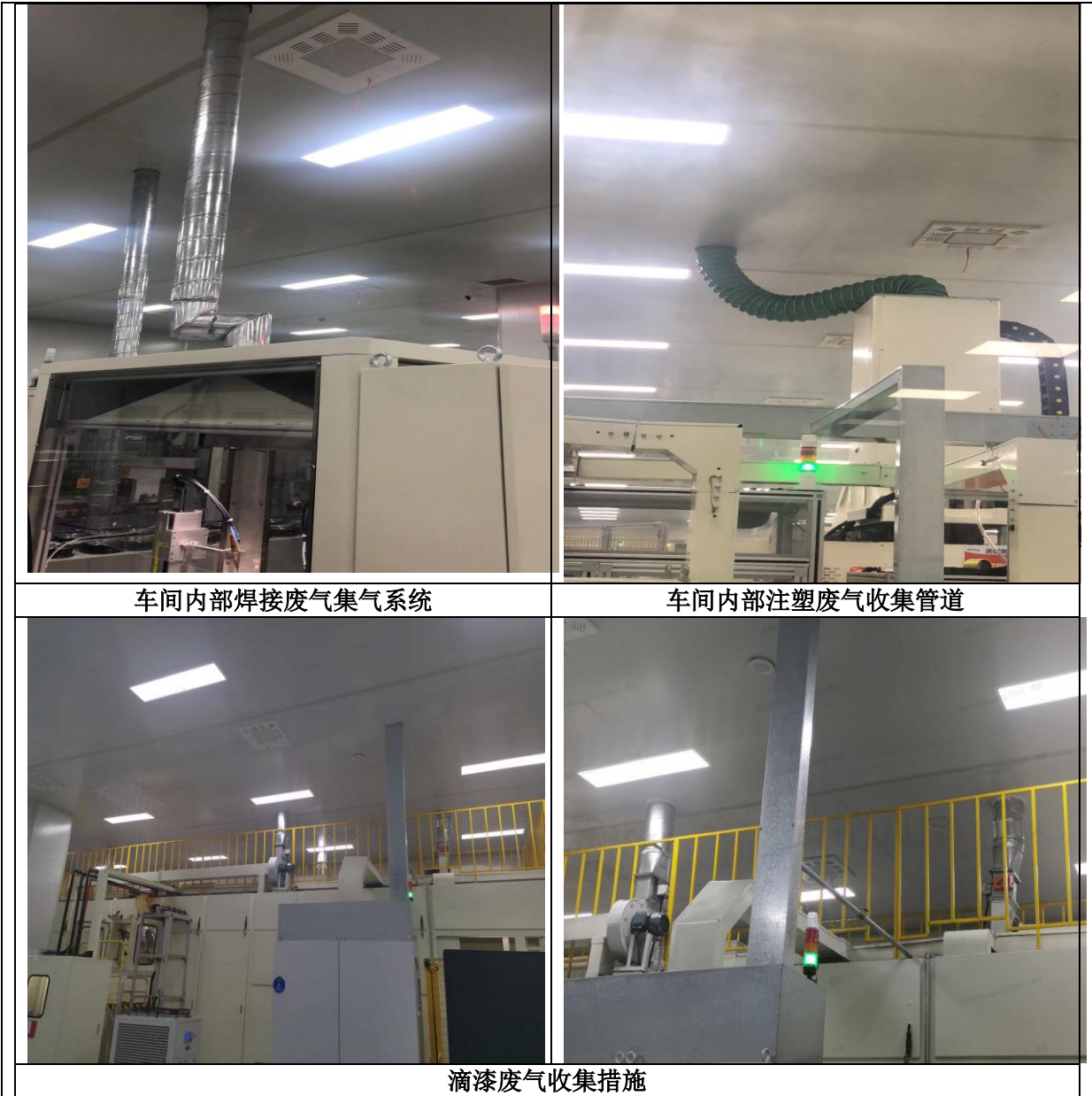
图 3-7 车间内废气收集和处置措施设施图片
