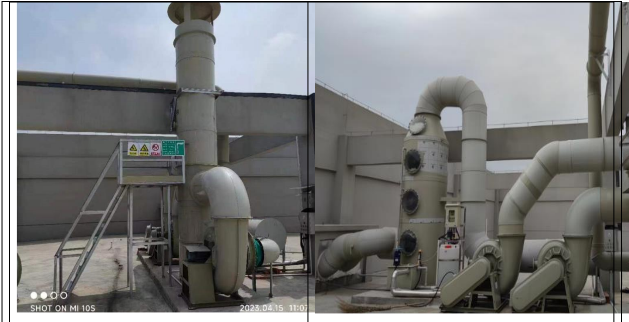
图 3-2 废气处理设施图片
