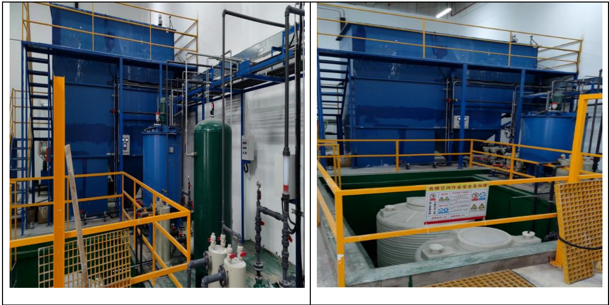
图 3-1 工艺废水预处理设施图片
