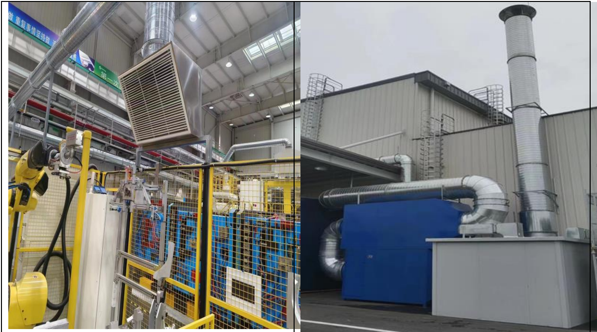
火焰处理废气收集系统
