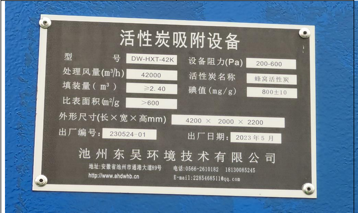
活性炭吸附设备相关参数 图 3-2 废气收集处理系统
