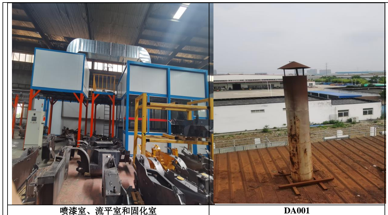
图 3-4 废气收集处理系统设施
