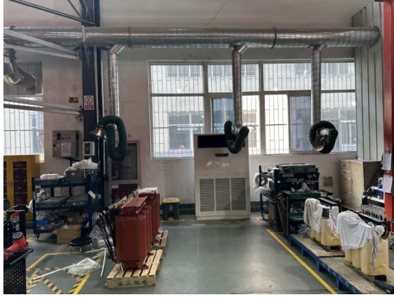
锡焊废气收集措施
