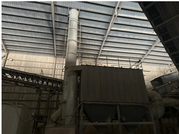
破碎、筛分粉尘收集以及布袋除尘器（DA001）
