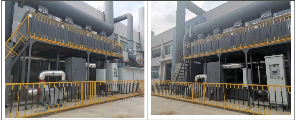
图 2-11 高效滤筒过滤器和机加工废气设施图片
