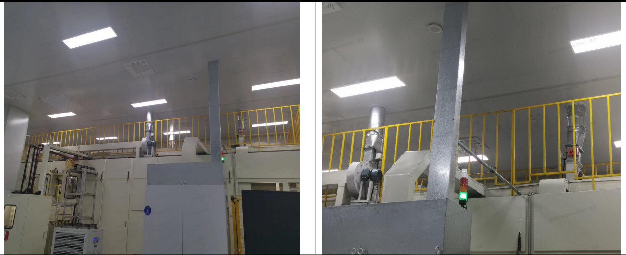
滴漆废气收集措施
