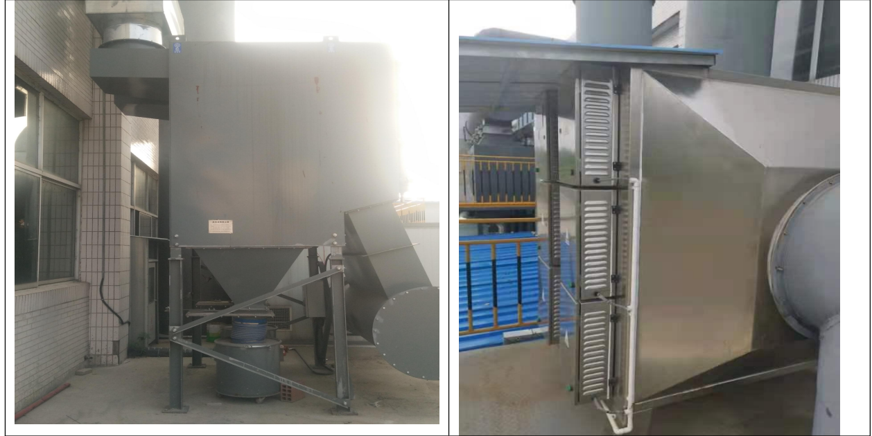
图 2-11 高效滤筒过滤器和机加工废气设施图片
